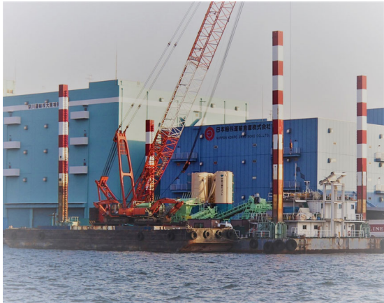
海上事前混合処理プラント
