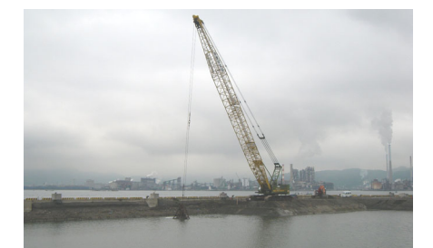
処理土投入状況
