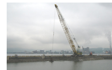
処理土投入状況
