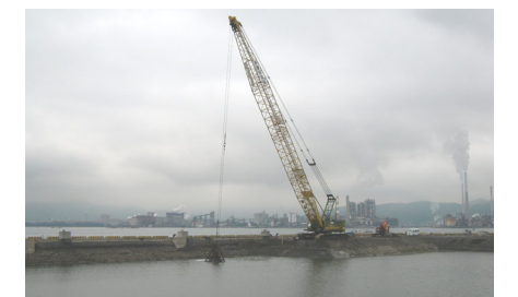
処理土投入状況
